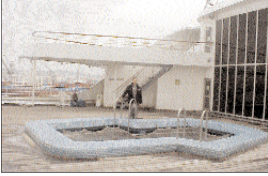
Onarımı büyük bir hızla devam eden geminin, çelik boru, saç kalıpları, bar ve oturma salonları ile jeneratör ve makine daireleri tamamen yenilendi.
