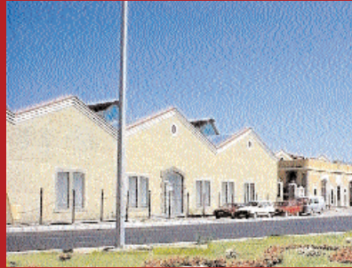
Alışveriş, kültür ve sanat merkezi olarak restore edilen Konak Pier, Günseli Kocagöz için İzmir'in yeni cazibe merkezi.
