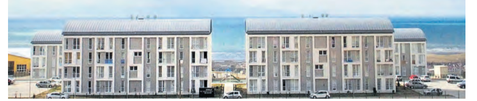
2011 Van depreminden sonra bölgedeki öğretmenlerin yaralarını sarmak için üçer katlı dört bloktan oluşan 128 dairelik lojmanlar, beş ay içerisinde inşa edildi.
